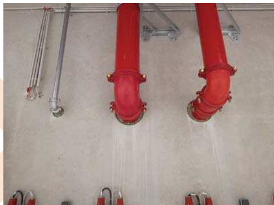
Ausführung mit Nachweis, Ausgangssituation: Rohre in DN 250, Ringspalt zu klein und „Verbindestörstellen“
